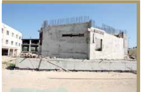
المبنى المدرسي الجديد (قيد الإنشاء - 2013)
