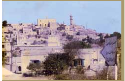
مركز درديغا الصحي- الاجتماعي، 1995
